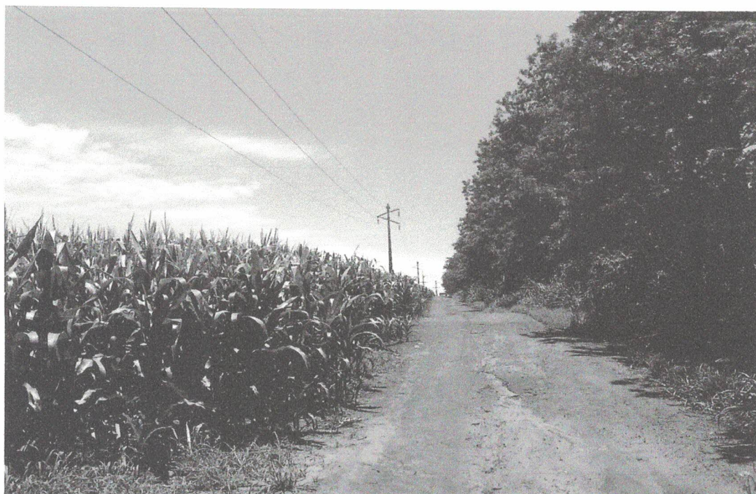
FIGURA 5A: VISTA PARCIAL DA SERVIDÃO DE PASSAGEM DE CABOS DE ENERGIA DE TENSÃO 138 kV.
